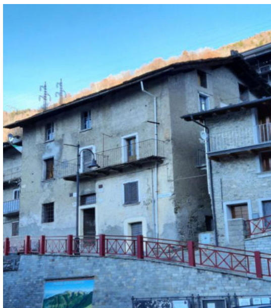
Figura 1: Immagine attuale del fabbricato "Canaloni"
