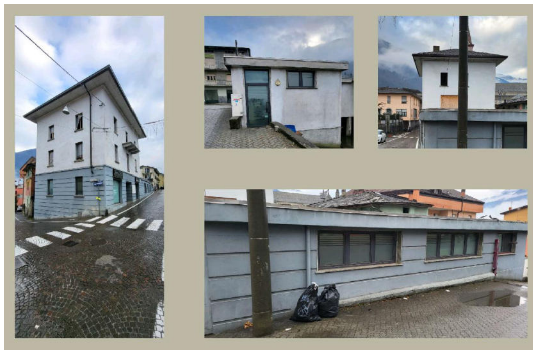
Figura: Documentazione fotografica dell'esistente
