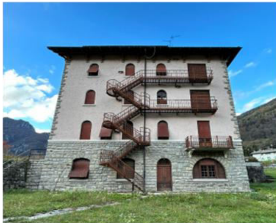
Prospetto Sud - Edificio A
